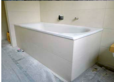
(6 + 7) Auch im Bereich der Sanitäranlagen fanden umfassende Sanierungsarbeiten statt.
